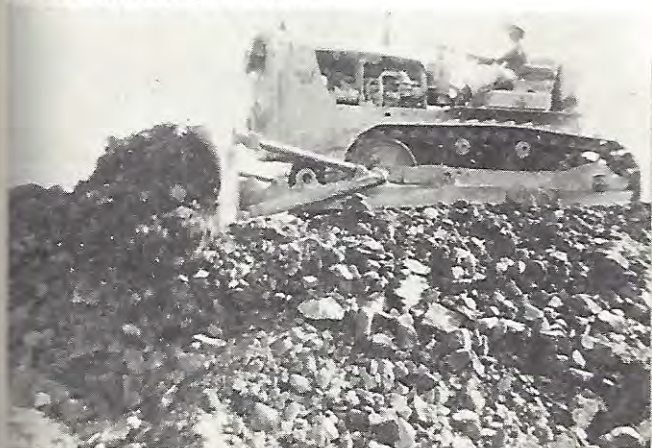
En construcción otras dos importantes carreteras, la de Huajuapán-Arteaga-Tonalá y la de Yucudichi-Mariscala.
