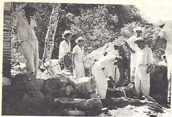
Aspecto de la construcción de un aljibe en la comunidad de Sta. Catarina Tenango. Soyalt, Oax.
