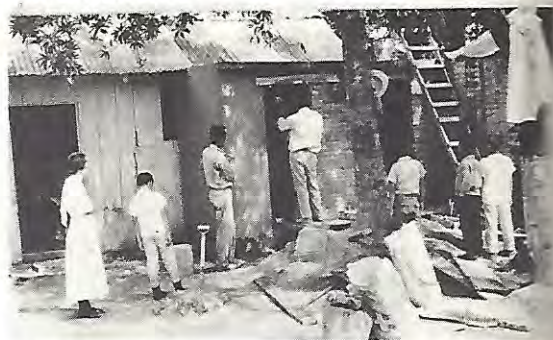
Construcción de sanitarios para la escuela "Guadalupe".—Matías Romero, Oax. Cooperación de la Sociedad de Padres de Familia.
