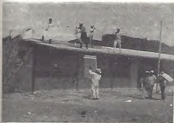
Vista relativa a trabajos materiales realizados en algunas escuelas de la zona escolar 38.
