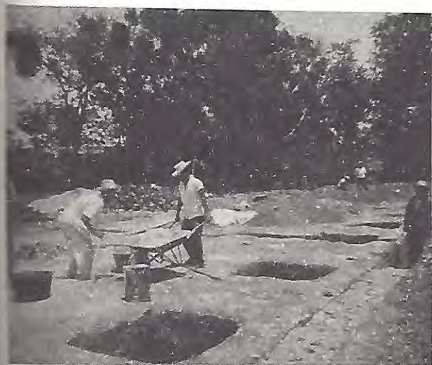
Iniciación de la construcción del nuevo edificio escolar en Tlaltepec de Candayoc, Mixe, Oax.
