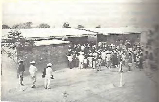
El pueblo en general observa con entusiasmo la obra terminada, coronación de sus esfuerzos. San Francisco Jaltepetongo, Noch., Oax.
