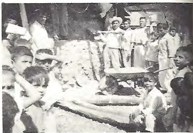
Construcción del horno para pan de los desayunos escolares. Escuela "Vista Hermosa". Tlaxiaco, Oax.
