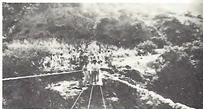
El pueblo de Tepalcatepec cooperando en la construcción de un puente colgante sobre el Río Grande en el camino que conduce a Quiegolani, Yaut. Trabajo realizado en 1959.
