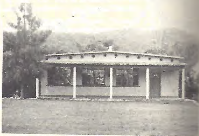
Edificio escolar construido por la Comisión del Papaloápam "población de reacomodo". La Nueva Patria, Coyalt, Oax.
