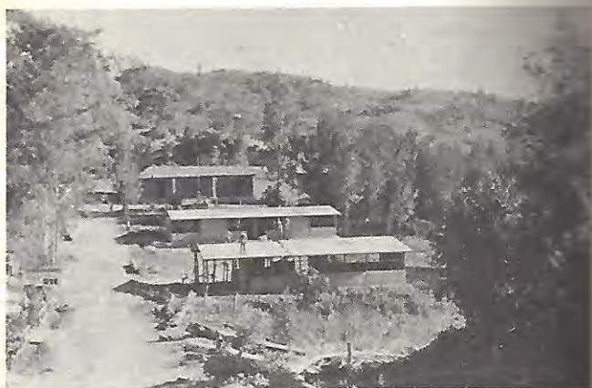
Otra vista fotográfica relativa a la construcción del edificio escolar, Guelatao, Oax.
