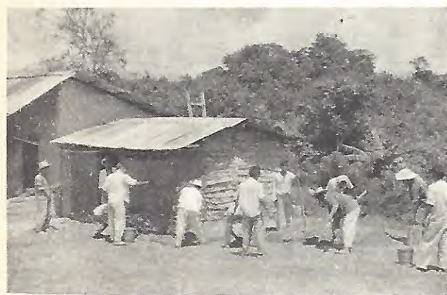
Construcción de la casa del maestro. Escuela "Boca del Monte", zona núm. 49. Matías Romero, Oax.
