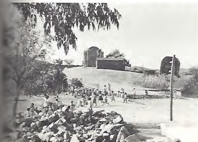
Alumnos y vecinos de San Luis Morelia, Tamazola, realizando trabajos para la construcción de una escuela.
