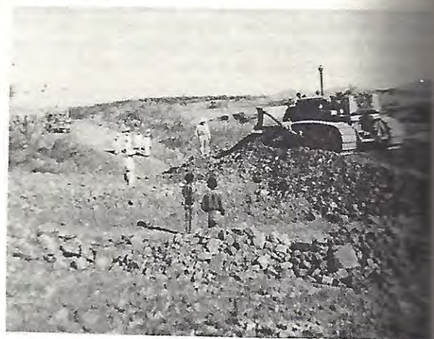
Otro aspecto de la construcción de la carretera Huajuapán-Tezoatlán.
