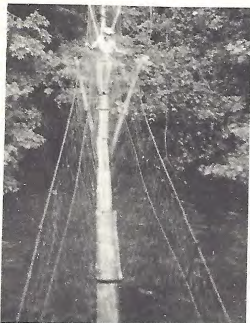
Como lo muestra la foto, el río se cruza en "Hamacas" construidas con alambre y bejuco, Choápan, Oax.
