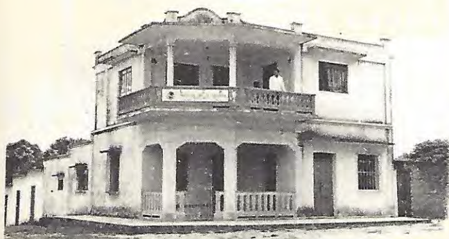
Oficina que ocupa la inspección escolar federal de la zona núm. 49. Matías Romero, Oax.
