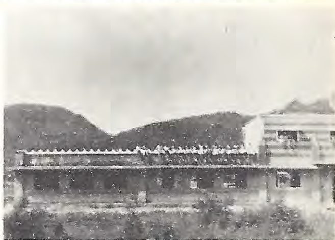
Escuela primaria Rural "Pascual Orozco".— Santiago Astata, Oax.
