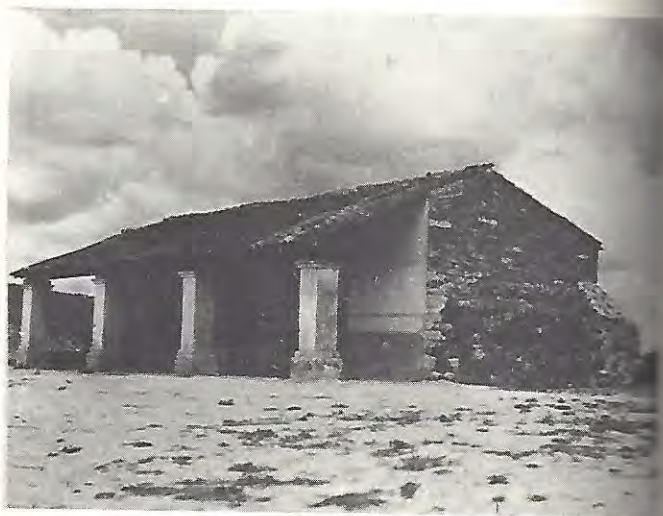
Edificio escolar, La Rosa, Teposcolula, Oax.
