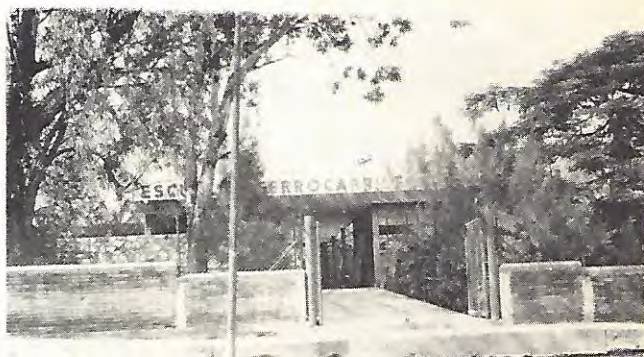
Entrada y vista del edificio de la escuela "FF. CC. Nacionales de México, Art. 123". Matías Romero, Oax.
