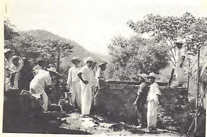
Fotografía relativa también a la construcción de un aljibe en la comunidad de Sta. Catarina Tenango. Soyalt, Oax.
