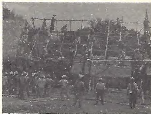
Construcción de un anexo escolar para teatro de la escuela de Río Manso, Oax.
