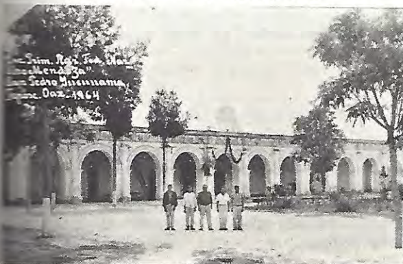
Edificio Municipal y Aulas de la escuela "Narciso Mendoza" San Pedro Yucunama, Teposc. Oax.
