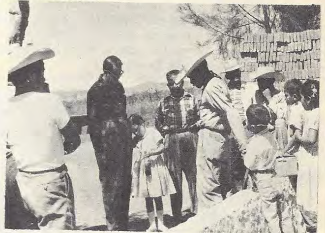
Construcción de la escuela Rural en el Ejido de Dolores, Centro, Oax.
