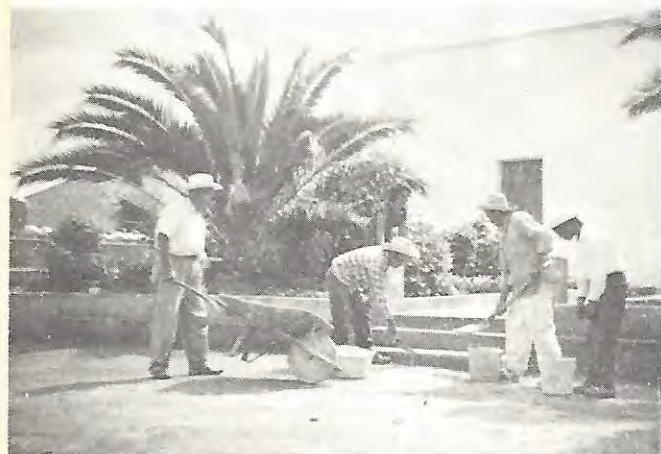
Terminación de la banqueta para 2 aulas. Yuyusa, Tejúpam, Oax.
