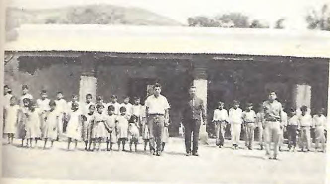
El Inspector Escolar Federal de visita en Totomachapam. La foto muestra la reconstrucción de la antigua escuela.
