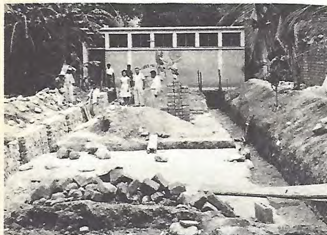
Construcción de Aulas escolares con la cooperación del H. Ayuntamiento y el C. A. P. F. C. E. Cuicatlán, Oax.
