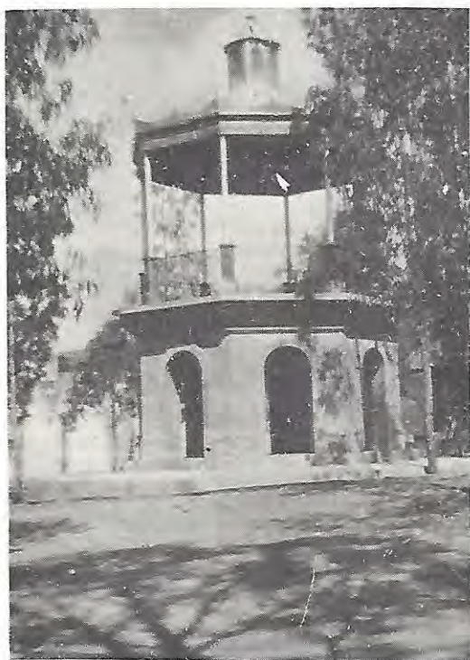
Vista parcial del Zócalo y Kiosco en Papalutla, Huajuapam de León, Oax.
