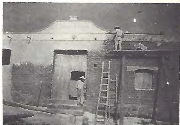
Realizando mejoras en la fachada de la escuela de Diquiyú.
