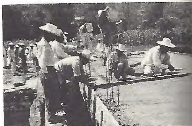
Construyendo una brecha con la cooperación de los vecinos. Santiago Apoala, Noch., Oax.
