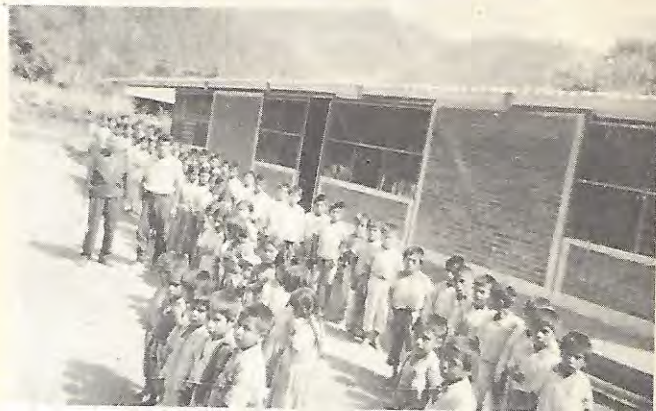
Otra visita del C. Inspector escolar a Miguel Hidalgo, Huit., Oax. Fotografía del nuevo edificio escolar y alumnos.
