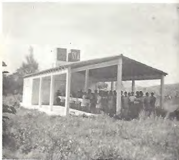
Actividades Sociales.—Fotografía relativa a la introducción de agua potable en una comunidad. Oaxaca, Oax.
