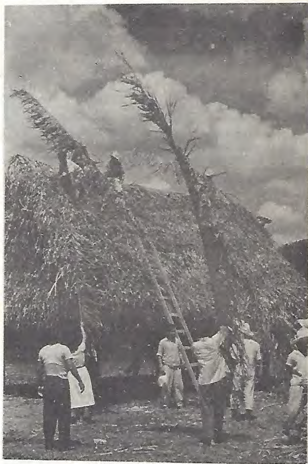
El trabajo colectivo todavía existe entre los indígenas. Construyendo una casa para el maestro, zona 47. Temascal, Oax.
