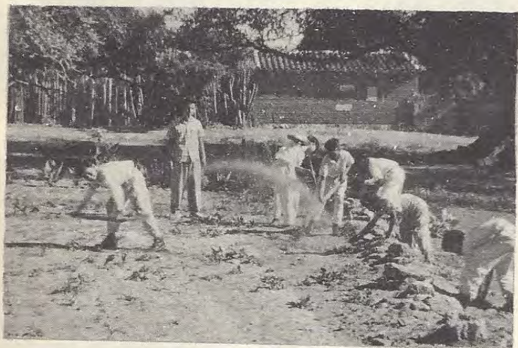
Alumnos de la escuela "Benito Juárez" nivelando el piso de la plaza para formar campos deportivos. Santa Ana Zegache, Ocot. Oax.
