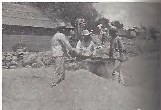
Reconstrucción de la casa del maestro en la población de San Bernardo Mixtepec.
