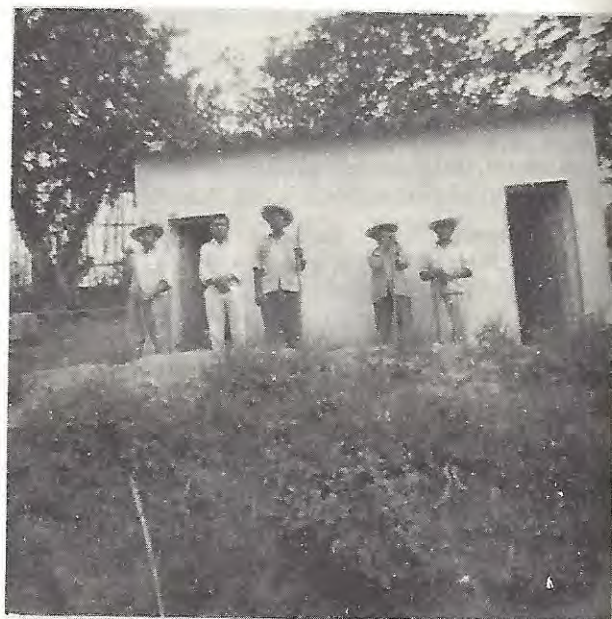
Baños de regadera para el servicio de la escuela "Benito Juárez", San Pedro Tepalcatepec. Oax.
