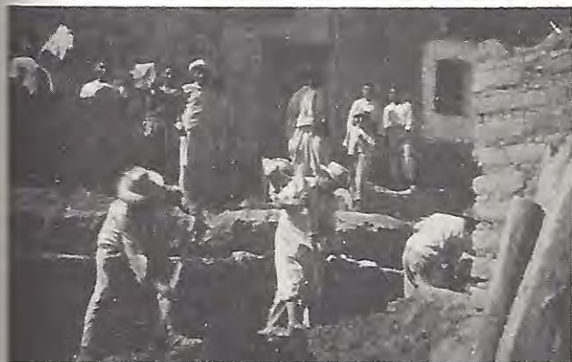
Trabajos para la ampliación de la casa del maestro. Tlahuitotepec, Mixe, Oax.
