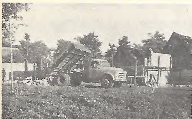
También el Centro Coordinador construye escuelas, es el edificio de la comunidad de Pescadito de en Medio, Soyalt, Oax.
