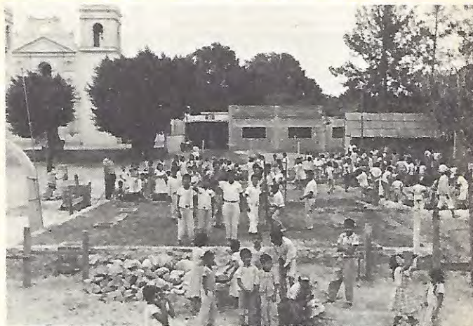
Arreglando el piso donde se construye la nueva escuela. San Martín de los Cansecos, Ejutla, Oax.
