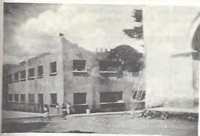
Escuela Primaria Federal. Villa Hidalgo, Oax. Construida en 1958 con un costo de $50,000.00.
