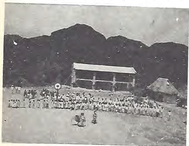
Nuevo edificio escolar en Camotlán. Costó $ 75,000.00
