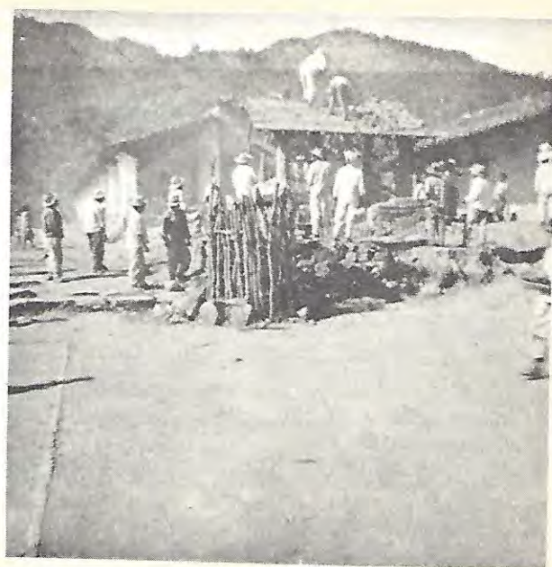
Comité pro-construcción del nuevo edificio escolar, iniciando el acondicionamiento del lugar. San Pedro Tepalcatepec, Oax.
