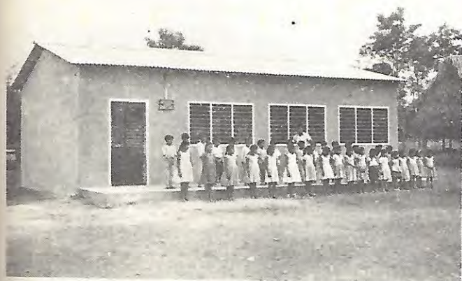
Aula ya terminada. Sus medidas son de 9 m. x 6 m. con persianas de madera, tela de alambre. Soyalt, Oax.
